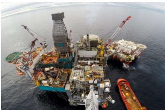
Rowan Viking rig, Edvard Grieg platform and flotel
